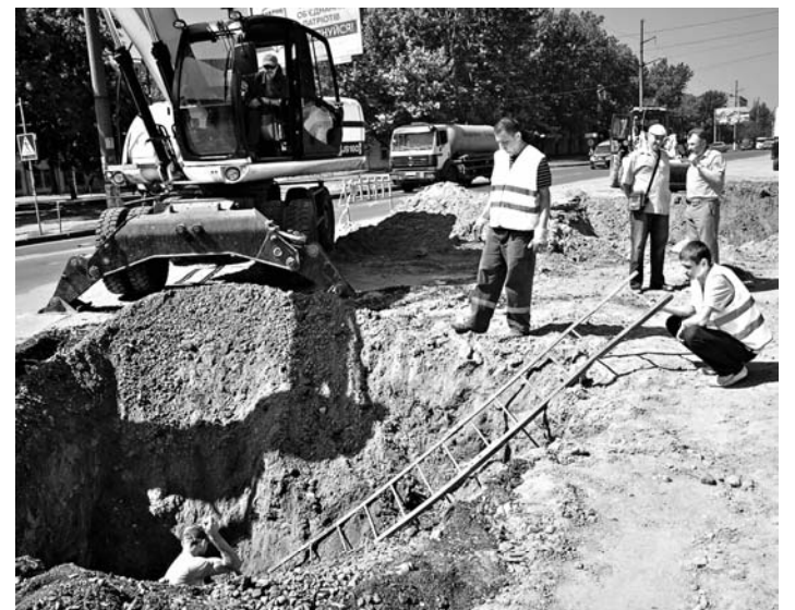
Ремонт каналізаційного колектора на вул. Космонавтів.
